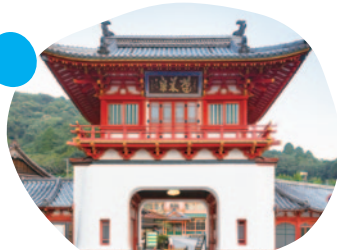
武雄温泉楼門
